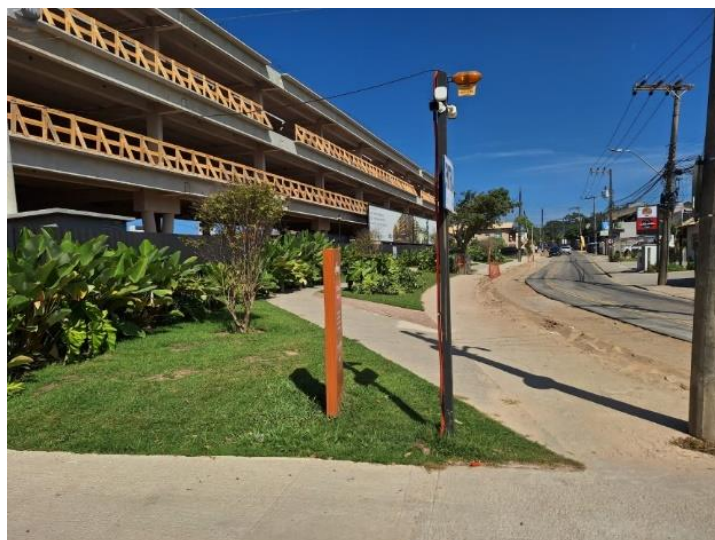
Imagem 2 - Fachada de construção, face de arruamento: adensamento e presença de edificação sem adaptabilidade de infraestrutura viária.
