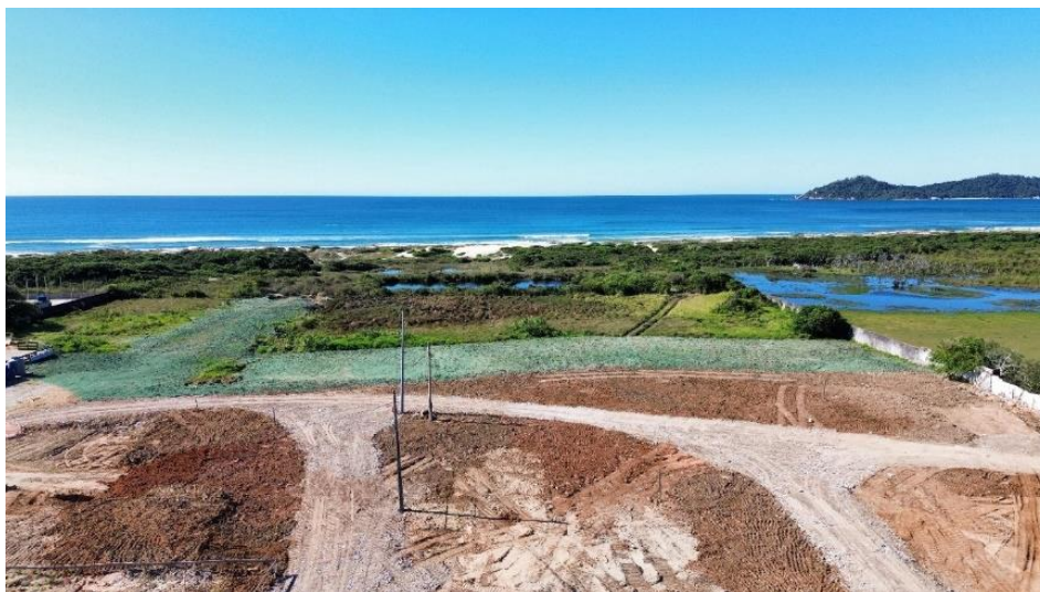
Imagem 1 - preparação de terreno para instalação de construção – alto padrão.
